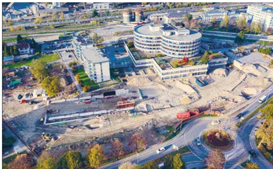
Chantier du parking de Brigue – 15.11.2022
